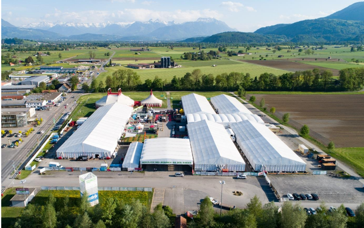
Bildlegende: Die RHEMA setzt weiterhin Akzente: 2020 wartet die beliebte Rheintalmesse mit einigen Neuerungen auf. Bild: air360.ch
